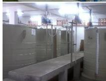
**Fluoretação e correção de pH:** o flúor é adicionado para auxiliar na prevenção da cárie e alcalinizante para neutralizar a acidez da água.
