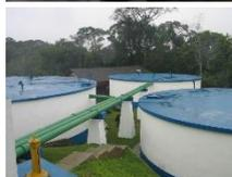
**Reservação:** concluído o tratamento, a água é armazenada em reservatórios com capacidade de 9.500m<sup>3</sup> de água e em seguida distribuída.
