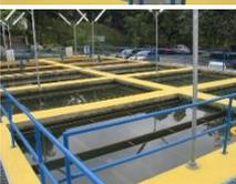
**Decantação:** por serem mais pesados, os flocos oriundos do floculador se depositam no fundo do decantador. A água limpa fica na parte superior e segue no tratamento.
